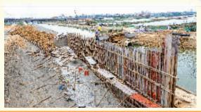
本报讯 5月22日,记者在锦江外线南侧与湿地公 园连接段工程现场看到,连接段的三个桥墩和左边的 挡土墙已浇筑完工。目前,工人正在对右边的挡土墙 进行绑钢筋作业。该连接线完工后,将极大方便游客 往来赏景。 (记者 颜华杰)
