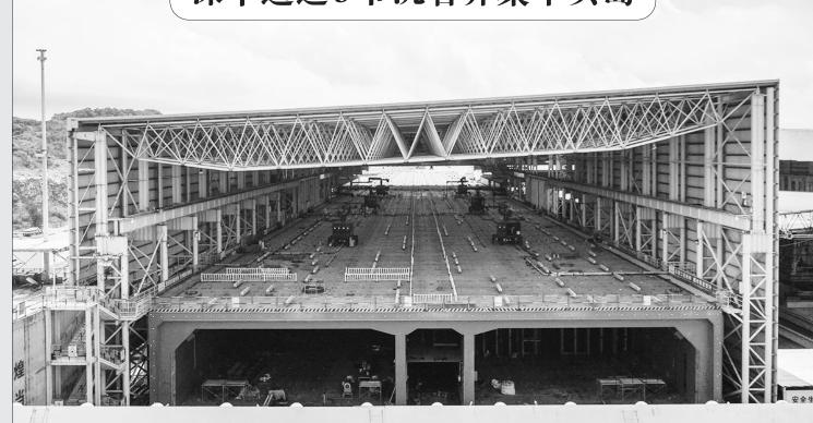
深中通道E20管节在中交四航局牛头岛沉管智慧工厂进行浇筑(无人机照片,4月24日摄)。
