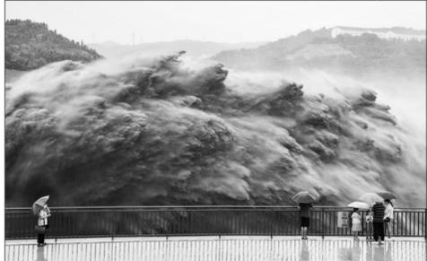
7月19日,游客观看黄河小浪底水库大流量泄洪。7月10日以来,黄河上中游地区发生了强降雨过程。为保障黄河下游防洪安全,黄河小浪底水库于7月17日开始防洪运作,提前降低库水位,留足防洪库容。
