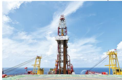
新华社深圳10月3日电 深水导管架平台“海基一号”3日在南海陆丰油田作业区正式投产。平台总高度达340.5米，总重量超4万吨，高度和重量均刷新了我国海上单体石油生产平台纪录。
