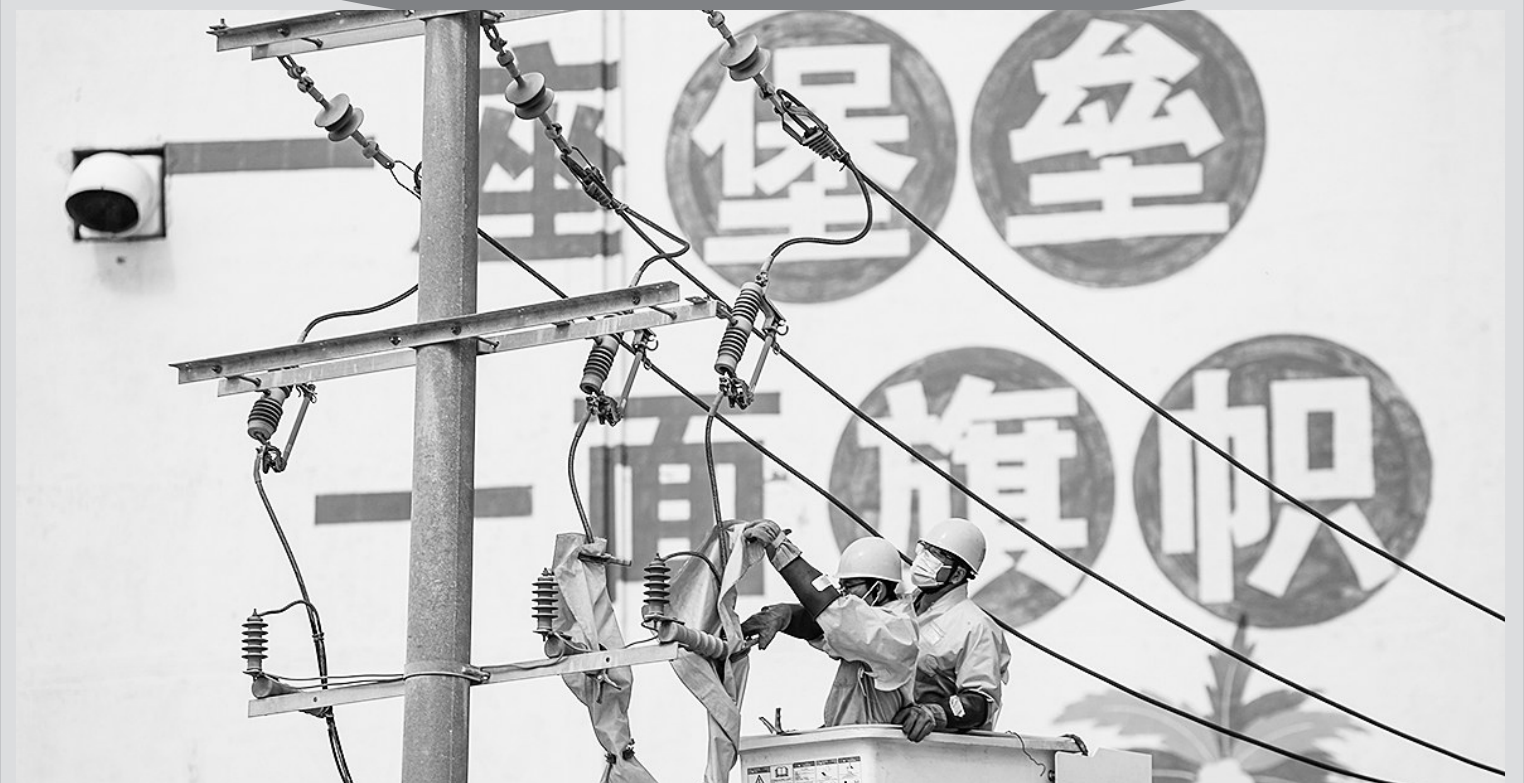
本报讯 10月12日，在东埔三村，国网石狮供电公司的工作人员正在带电作业，对东埔三村#2公用变支路分段G6153刀闸两侧端子进行绝缘包扎，防止因异物、小动物造成的短路，提升配网的健康运行水平，减少配网故障的发生，降低人身触电风险，保障居民可靠用电。 （记者 颜华杰 通讯员 蔡灵智）
