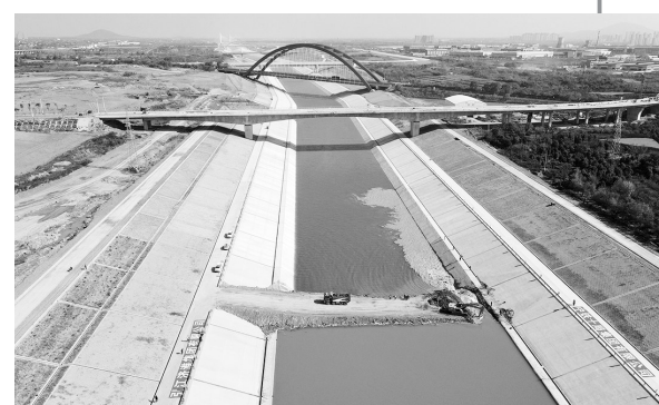
▲引江济淮工程菜巢线通水 10月13日，中铁十局三建公司施工机械在引江济淮工程河道上拆除围堰(无人机照片)。
