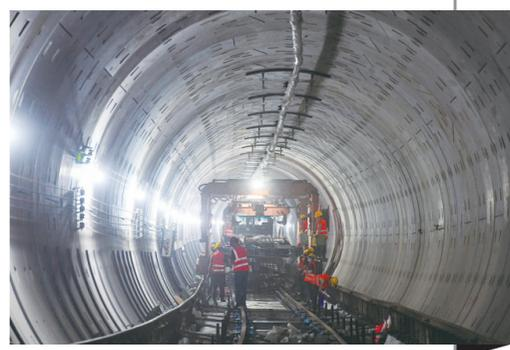
10月26日，施工人员在广州地铁11号线隧道内吊装轨道。
