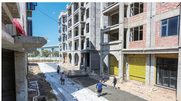
福厦客专(蚶江段)水头村安置区道路工程加速建设,截至目前,已完成所有隐蔽工程、道路路基和水稳层铺设施工,已完成1条主通道和8条区间路路面混凝土浇筑施工,并完成道路的雨、污水管道施工。
