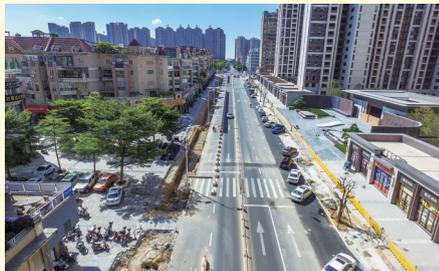
近日,回兴路(九二东路—东港路)完成半幅主路拓宽,原来的2车道已拓宽为3车道,树池里同步种上了绿化树。目前,已转入另一幅主路施工。
