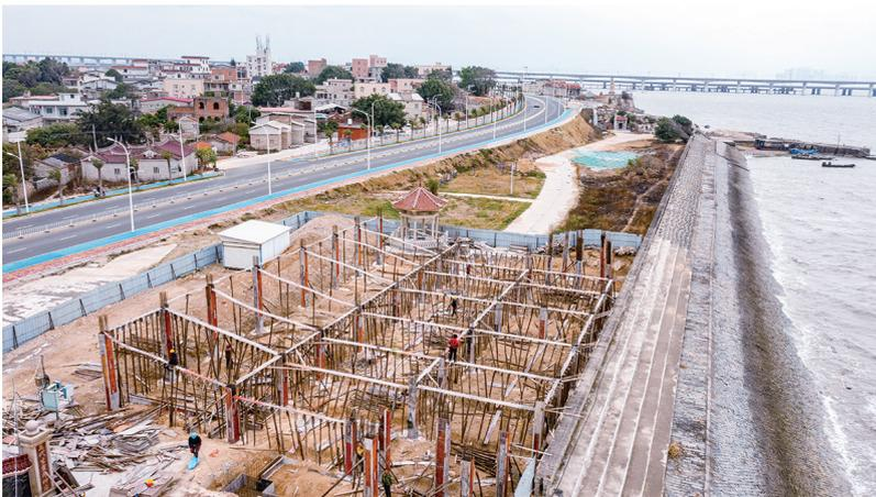
11月4日,记者在锦江外线后垵澳段的蚶江观海平台项目施工现场看到,施工人员正进入地上部分第一层的脚手架搭建以及钢筋、梁模板、楼层模板环节施工,项目整体工程正有序推进。据悉,该项目占地面积900多平方米,建成后将于闽台对渡节暨蚶江海上泼水节开幕式表演及游客赏海。
