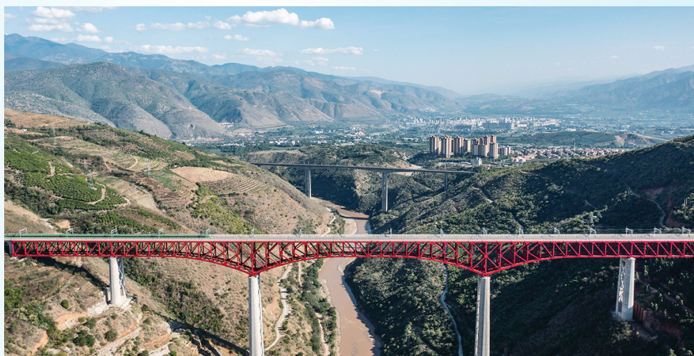
▲11月23日,复兴号列车通过中老铁路元江特大桥(无人机照片)
