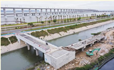
12月5日,记者前往锦江外线连接湿地生态公园的车行桥项目现场看到,小桥斜坡式接地的部分已经吊装好了预制梁板,将马上进行桥面铺装,该项目将力争在年底完工。
