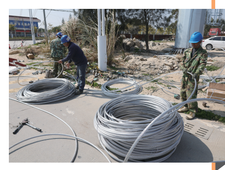
准备好更换新的电线
