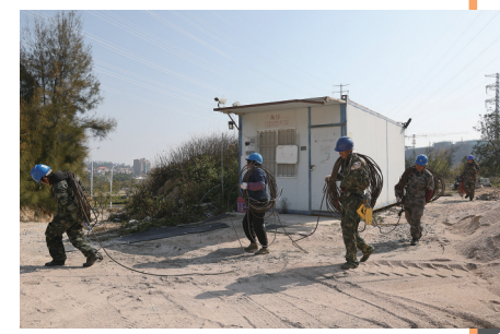
施工人员将物资运送到位
