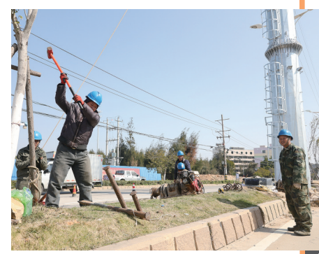
在钢管杆一侧设置固定锚点
