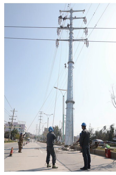
高空施工需要有地面人员的密切配合
