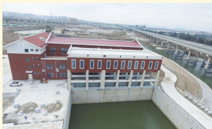
石狮水头排涝枢纽工程主泵房高颜值呈现。项目自2020年6月开工以来,在业主单位、施工单位和监理单位的携手攻坚下,工程即将投入使用。(记者 兰良增 李荣鑫)
