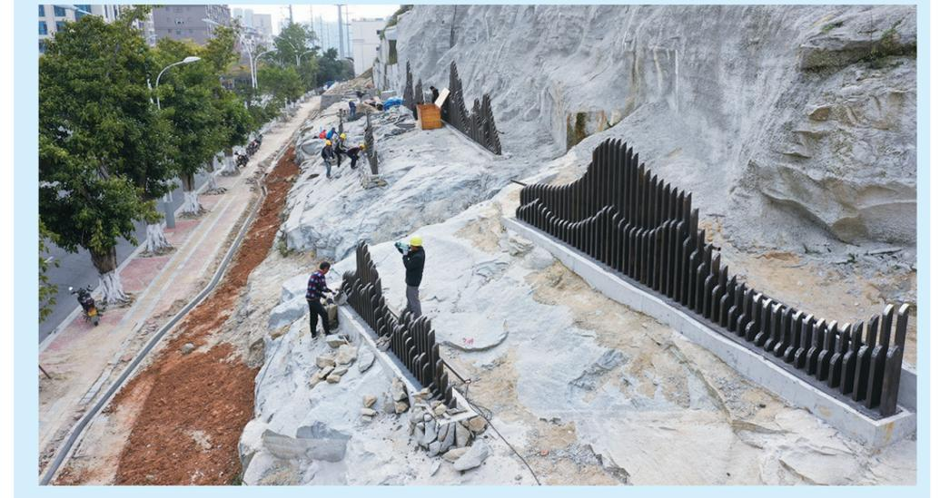
本报讯 这两天,经过南环路的市民会发现,在风炉山公园北入口(通往华林寺)边上,完成削坡、喷浆后的一处裸露边坡,施工人员正通过浇筑水泥石灰土的方式,将几座假山状的铁艺小品,固定在坡度相对缓和的位置上。据国投集团园林绿化公司相关负责人介绍,随后还将种植爬山虎、矮蒲葵等绿植,并配套照明工程,以绿化、亮化、美化相结合的方式,让风炉山公园这一局部“门面”更加靓丽,打造为公园又一值得“打卡”的景观节点。风炉山公园景观提升前两年已完成。在南环路通过削坡等方式完成落
