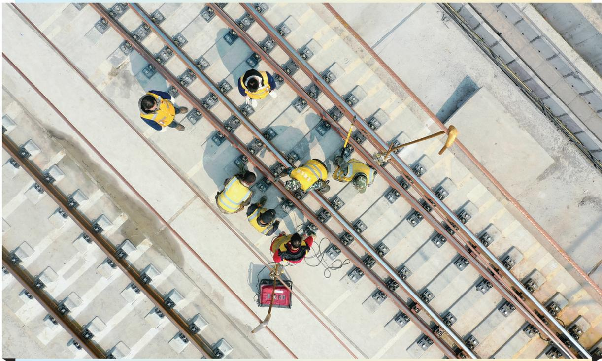
2月27日，在贵南高铁都匀东站附近，贵阳高铁工务段的技术人员进行精调工作(无人机照片)。近日，新建贵阳至南宁高铁开始进入轨道精调冲刺阶段，为正式开通运营奠定基础。
