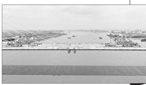
▲粤港澳大湾区：南中高速洪奇门特大桥合龙 5月21日，南中高速洪奇门特大桥顺利合龙(无人机照片)。当日，由中铁大桥局承建的南中高速洪奇门特大桥顺利合龙。洪奇门特大桥全长1126米，为主跨520米的双塔双索面钢箱梁斜拉桥，是南中高速项目的关键控制性工程。
