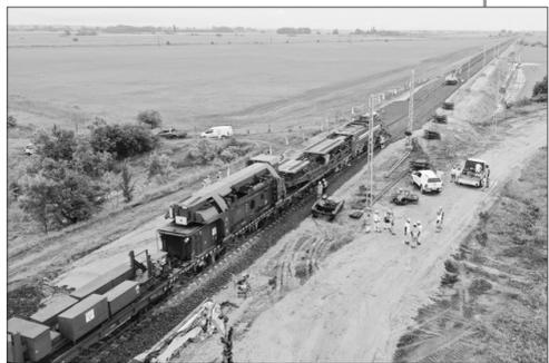
▲匈塞铁路匈方利段全面进入铺轨施工阶段 这是5月30日拍摄的匈塞铁路匈方利段孔圣米克洛什-陶什站施工现场(无人机照片)。匈塞铁路匈方利段孔圣米克洛什-陶什站至伯特斯特站区间首对钢轨30日开始铺设。随着首对钢轨落入承轨槽,匈塞铁路匈方利段中方段正式启动铺轨工作,标志着匈塞铁路匈方利段全面进入铺轨施工阶段。(新华)
