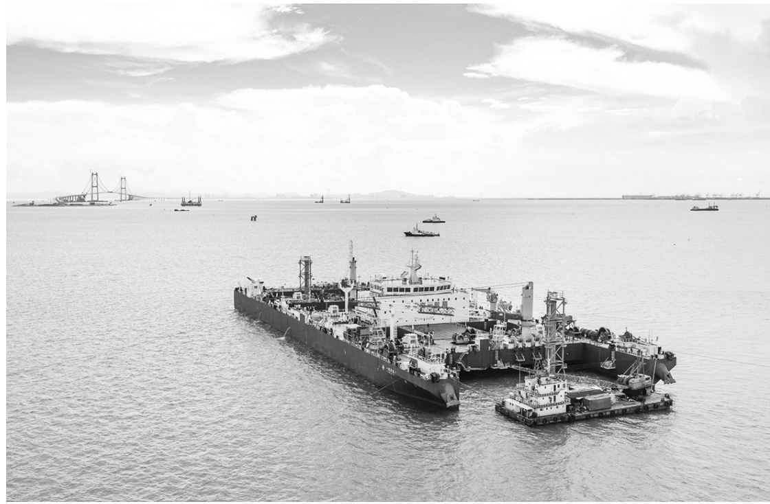
▲“一航津安1”号沉管运输安装一体船在沉放安装E23管节和最终接头，背后是建设中的深中通道伶仃洋大桥(6月9日摄，无人机照片)
