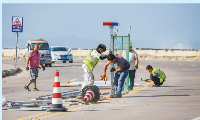
国道G228线提升改造工程施工单位拆除施工围挡
