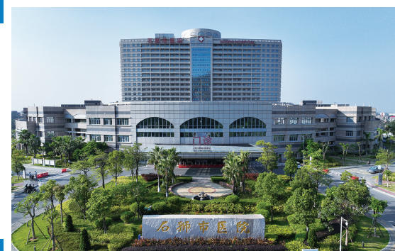
王王伟、王永权捐建石狮新医院门诊大楼
