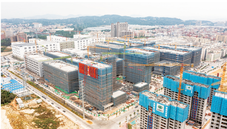
10月27日上午，在石狮网商园中部，标准厂房配套的员工宿舍楼浇筑好最后一方混凝土，实现了主体结构封顶。至此，整个标准厂房和仓储研发项目，所有功能楼便全部封顶，全面转入砌体和装修阶段。(记者 康清辉 颜华杰)
