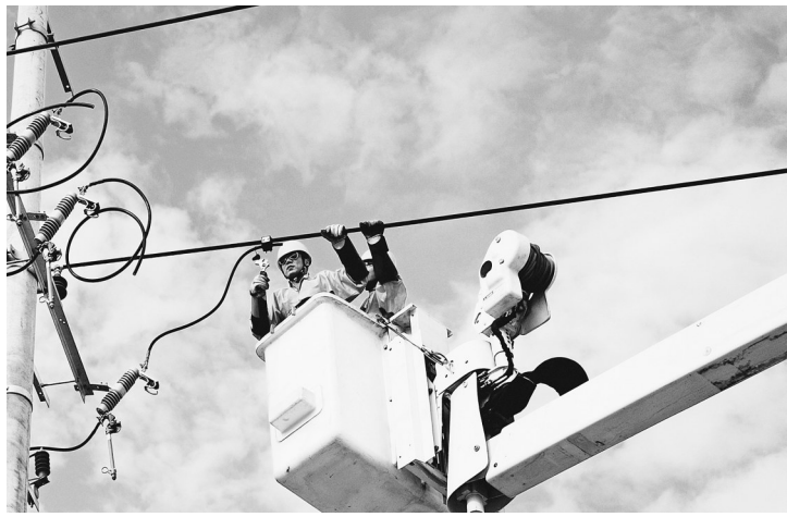
当前该公司正快马加鞭高质量推进多项电网建设重点项目。前段时期,石狮五金110千伏变电站1、2号主变吊罩安装顺利完成,为工程早日竣工投运奠定坚实基础。
