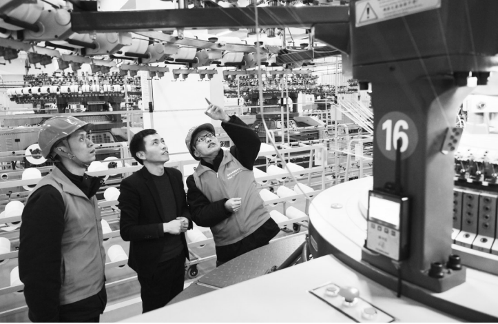
“破难题、促发展”专项行动与助力打造“三大三先”省级高质量发展示范电网,聚力打造高能级配电网示范相结合,并全力攻坚110千伏五金输变电等工程。
