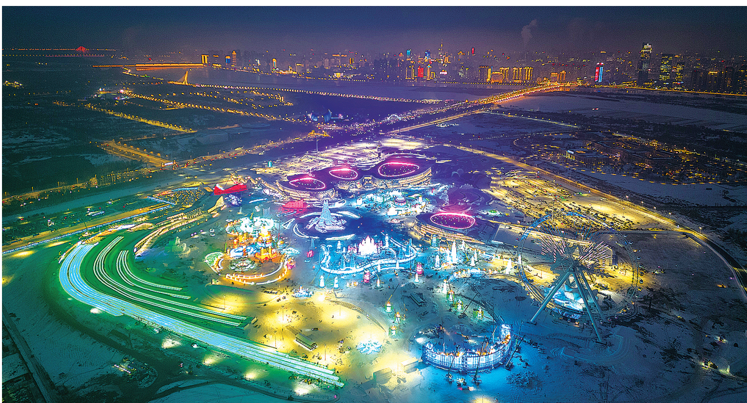
▲雕冰塑雪建设火 冰雪世界“逆”寒潮 12月12日,工人在哈尔滨冰雪大世界园区建设现场施工(无人机照片)。以“龙腾冰雪 逐梦亚冬”为主题的第二十五届哈尔滨冰雪大世界将于12月18日开园迎客。目前在园区内,林立的塔吊、穿梭的机械交织成一首忙碌的建设“交响曲”。本届哈尔滨冰雪大世界将使用25万立方米的冰和雪,倾力打造一个梦幻精彩的冰雪童话世界。(新华社)
