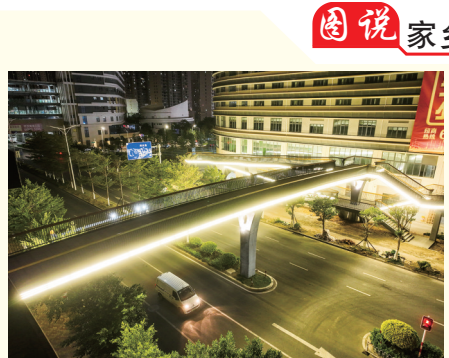
石狮花园路人行天桥工程于近日全部完工。夜幕来临,天桥亮起彩灯,来往车辆穿梭于下,一派车水马龙。(记者 李荣鑫)
