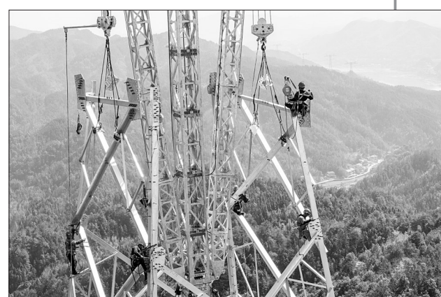
3月12日，电力工人在安化县冷市镇进行组塔作业(无人机照片)。 当日，在湖南省益阳市安化县冷市镇，湖南省送变电工程有限公司电力工人抓紧推进“宁电入湘”工程组塔工作，力争项目早日建成运营。 据了解，“宁电入湘”特高压线路工程是我国首个沙漠、戈壁、荒漠地区风电光伏基地外送电的特高压工程。工程建成投运后，湖南将用上来自西北的清洁能源，每年可从宁夏向湖南输送电量超360亿度，减少二氧化碳排放超1600万吨，有效提升湖南地区电力供应保障能力，实现湖南中长期电力供需平衡。(新华)
