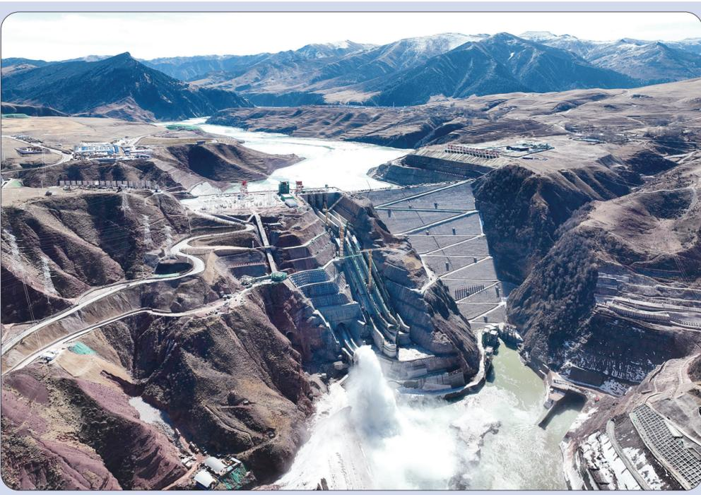
▲黄河流域在建海拔最高、装机最大水电站首台机组并网发电 这是4月1日拍摄的玛尔挡水电站(无人机照片)。4月1日,玛尔挡水电站首台5号机组正式并网发电。该水电站位于青海省海南藏族自治州同德县与果洛州玛沁县交界处的黄河干流上,项目所在地平均海拔3300米,总装机容量232万千瓦,是黄河流域在建海拔最高、装机最大的水电工程,属于国家和青海省重点能源项目,也是国家实施“西电东送”和“青电入豫”的骨干电源点,电站预计2024年12月实现全部机组投产发电。(新华社)
