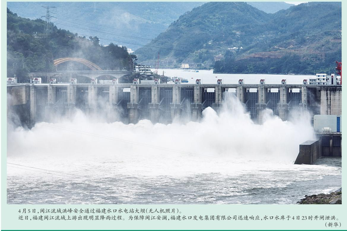
4月5日,闽江流域洪峰安全通过福建水口水电站大坝(无人机照片)。近日,福建闽江流域上游出现明显降雨过程。为保障闽江安澜,福建水口发电集团有限公司迅速响应,水口水库于4日23时开闸泄洪。(新华)
