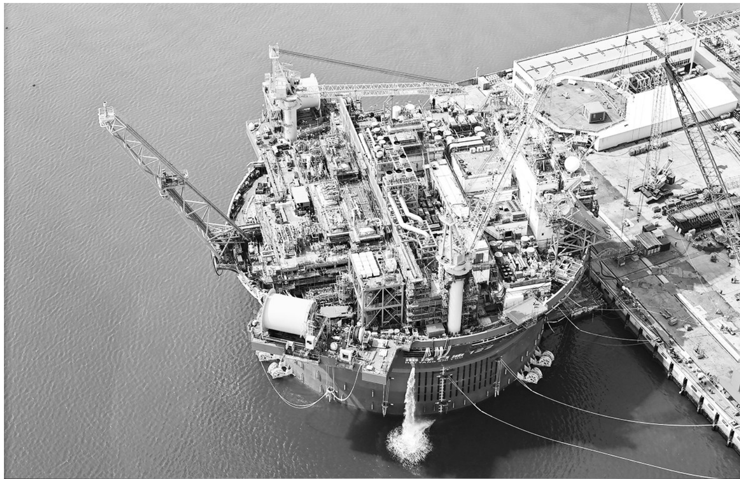
▲山东青岛:“海上油气加工厂”进行倾斜试验 4月7日,“海洋石油122”浮式生产储卸油装置(FPSO)在海油工程青岛场地进行海上倾斜试验及调试(无人机照片)。当日,由我国自主设计建造的亚洲首艘圆筒型“海上油气加工厂”——“海洋石油122”浮式生产储卸油装置(FPSO),在海油工程青岛场地进行海上倾斜试验及调试,为项目年内投产奠定基础。“海洋石油122”被称为“超级能源碗”,最大排水量10万吨,最大储油量6万吨,可连续在海上运行15年不回坞。(新华)
