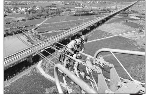
▲华东能源通道迎来“体检” 4月9日,在位于安徽省合肥市庐江县郭河镇的直流±800千伏建苏线3418号杆塔处,国网合肥供电公司工人进行高空检修作业(无人机照片)。4月4日至4月15日,直流±800千伏建苏线开展年度检修工作。通过本次全面检修,将进一步提升建苏线的供电可靠性。直流±800千伏建苏线是我国“西电东送”大通道之一,全长2080公里,途经四川、重庆、湖北、安徽5省市,每年可为江苏输送清洁电能超300亿千瓦时。(新华社)
