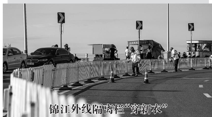
本报讯 5月28日，记者在锦江外线看到，几名工人正在对隔离栏进行除锈刷漆维护。由于日晒雨淋等原因，该路段隔离栏出现不同程度的锈蚀生漆、油漆脱落现象，影响了栏杆使用寿命。现场工人告诉记者，他们对栏杆表面锈迹进行清理，紧接着进行刷漆维护，刷漆后的隔离栏可为过往行人车辆提供良好的防护作用。（记者 颜华杰）
