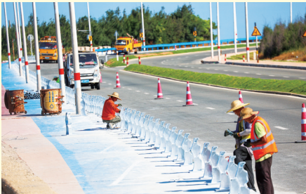
6月30日,在国道G228公路哨所公园段,工人师傅们正头顶烈日进行防撞护栏安装等作业,完工后将为过往车辆和行人提供更加可靠的安全保障。 (记者 颜华杰)
