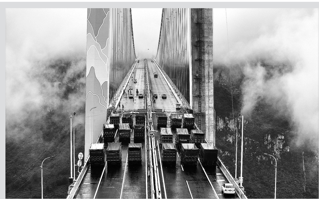
▲在建世界第一高桥正式启动荷载试验 8月21日，在建世界第一高桥——贵州花江峡谷大桥正式启动荷载试验。2022年开工建设的花江峡谷大桥，跨越被誉为“地球裂缝”的花江大峡谷，是贵州省六枝至安龙高速公路的控制性工程。大桥为钢桁梁悬索桥，全长2890米，其中主桥跨径1420米，桥面至水面高度625米。（新华）
