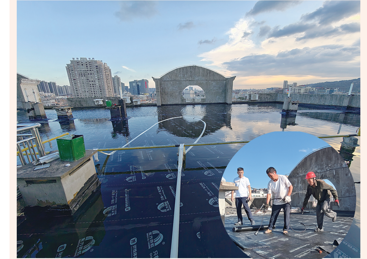
图为施工现场
