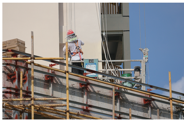
▲前园片区安置房项目外墙喷涂作业
