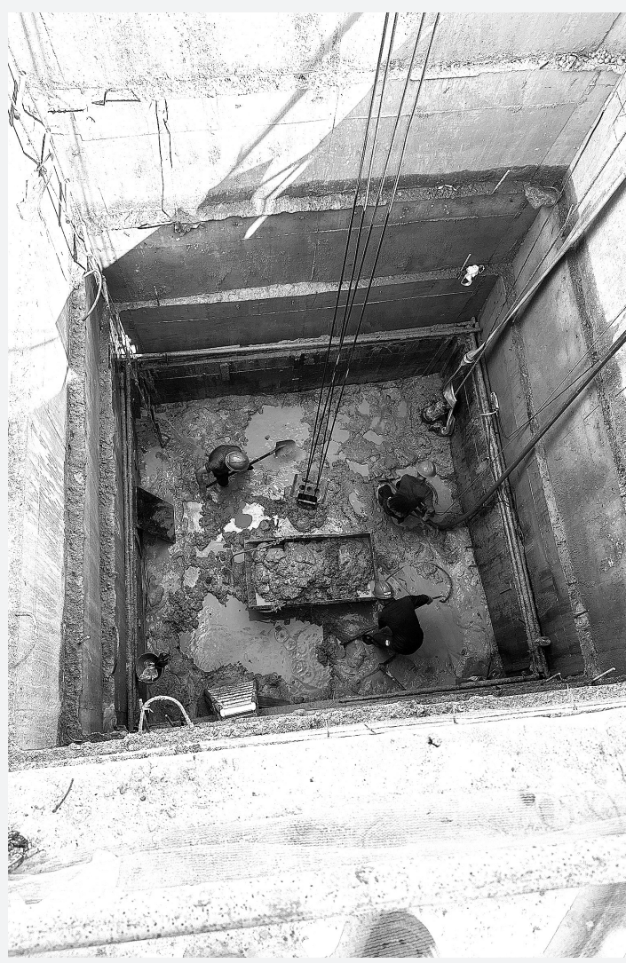
东沟上游污水管道连通工程顶管段逆作井施工现场
