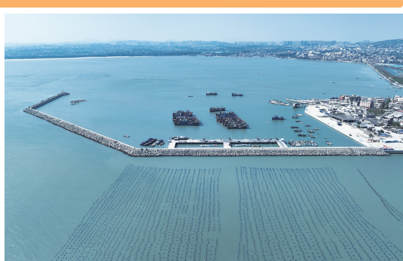
日前,福建省石狮市梅林一级渔港项目竣工初验评审会在永宁镇召开。与会专家和代表实地核查码头、防波堤、渔港配套设施等关键工程的建设质量与完成情况。随后,会议听取建设单位、设计单位、施工单位、监理单位的工作报告,查阅相关资料并经过讨论后,同意福建省石狮市梅林一级渔港项目通过竣工初步验收。
