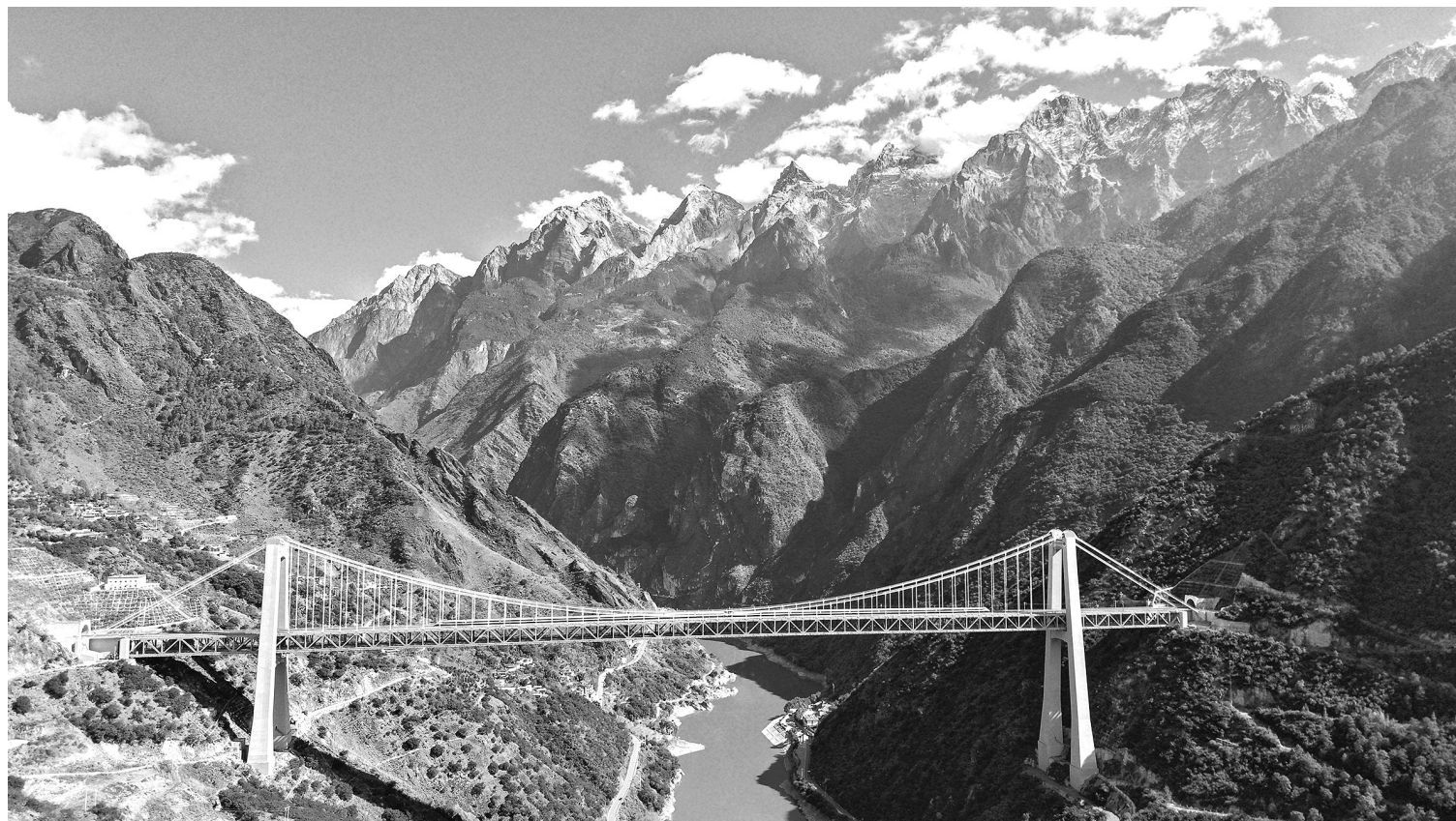
▲一条“云岭天路”串起的幸福密码 这是11月21日拍摄的虎跳峡金沙江铁路大桥。大桥全长882.5米，起于玉龙雪山隧道出口，止于哈巴雪山隧道进口，是丽香铁路的重点控制性工程(无人机照片)。2025年11月26日，我国滇藏铁路重要组成部分——丽江至香格里拉铁路(下称“丽香铁路”)，将迎来开通运营两周年。这条连接丽江与香格里拉的“云岭天路”全长139.7公里，结束了云南迪庆藏族自治州不通铁路的历史。丽香铁路开通运营两年来，客货运输量质双升，沿线各族群众“人享其行、货畅其流”的美好愿景成为现实。铁路不仅带来了稳定的客流，让不少村民在家门口吃上了“旅游饭”，也使公铁联运项目逐步增多，让丰富的物资源源不断通过铁路走出高原。丽香铁路既是交通线，又当地的“经济线”“幸福线”。展望“十五五”，丽香铁路将有力提升民族地区运输服务保障能力，助力区域经济高质量发展。(新华)
