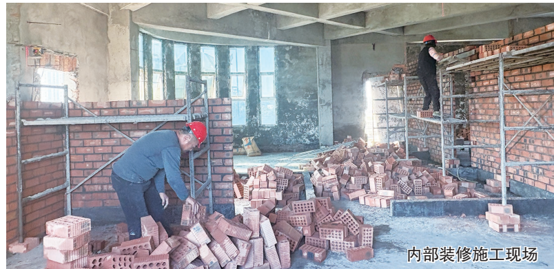
内部装修施工现场
