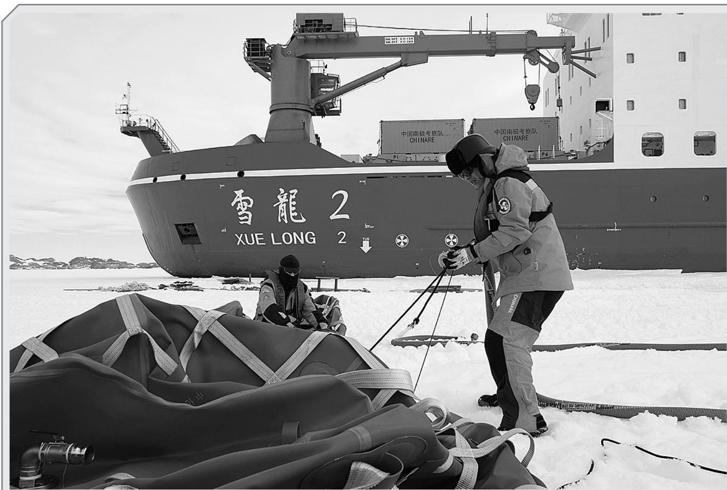
▲“雪龙2”号首次参与中山站燃油补给 北京时间12月2日傍晚,工作人员在做油囊加注准备工作。近日,正在执行中国第42次南极考察任务的“雪龙”号抵达南极中山站外缘冰。“雪龙2”号已于北京时间11月25日率先抵达该区域。两船正协同开展中山站区域大规模卸货作业。本次作业将累计完成约2000吨各类物资卸运。按计划,整体卸货作业将持续约15天。据“雪龙2”号轮机长李文明介绍,“雪龙2”号是首次为考察站补给燃油,需要为中山站卸运约500吨燃油,计划以每日150至180吨的卸油速度推进。(新华)
