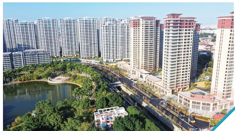
龟湖东片区安置房及周边道路改造完成
