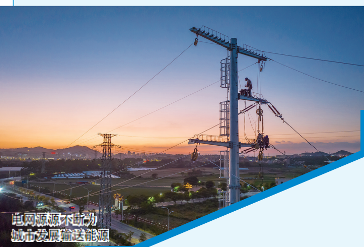
带电作业保障可靠供电
