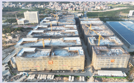
作为2025年省级重点项目,腾讯云·中重数字孪生产业园项目建设近日捷报频传,一期、二期工程已有23栋楼主体结构封顶,为区域数字经济高质量发展注入强劲动力。(记者 兰良增 李荣鑫)
