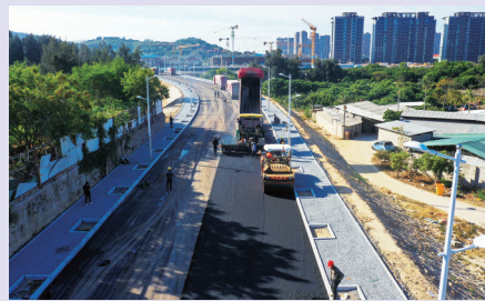
近日,连接府园路与石锦路的锦园路,开始主路底层沥青的铺设。据悉,该路段将力争春节前实现完工通车。(记者 康清辉 颜华杰)
