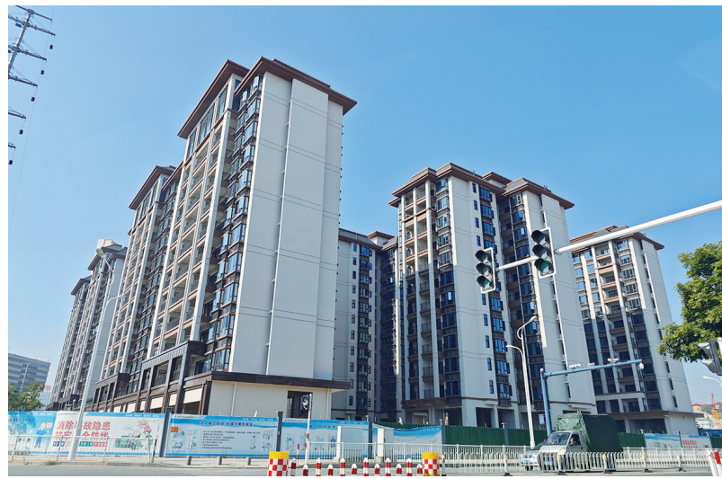
2025年即将收官,位于灵秀镇灵山村的“电商人才家园”——灵山华庭小区施工进入尾声,9栋带坡屋顶的小高层,现代风格的立面已清晰呈现。当下,项目正抓紧进行室外的管网铺设等施工,计划在2026年春节前完工。(记者 康清辉 李荣鑫)
