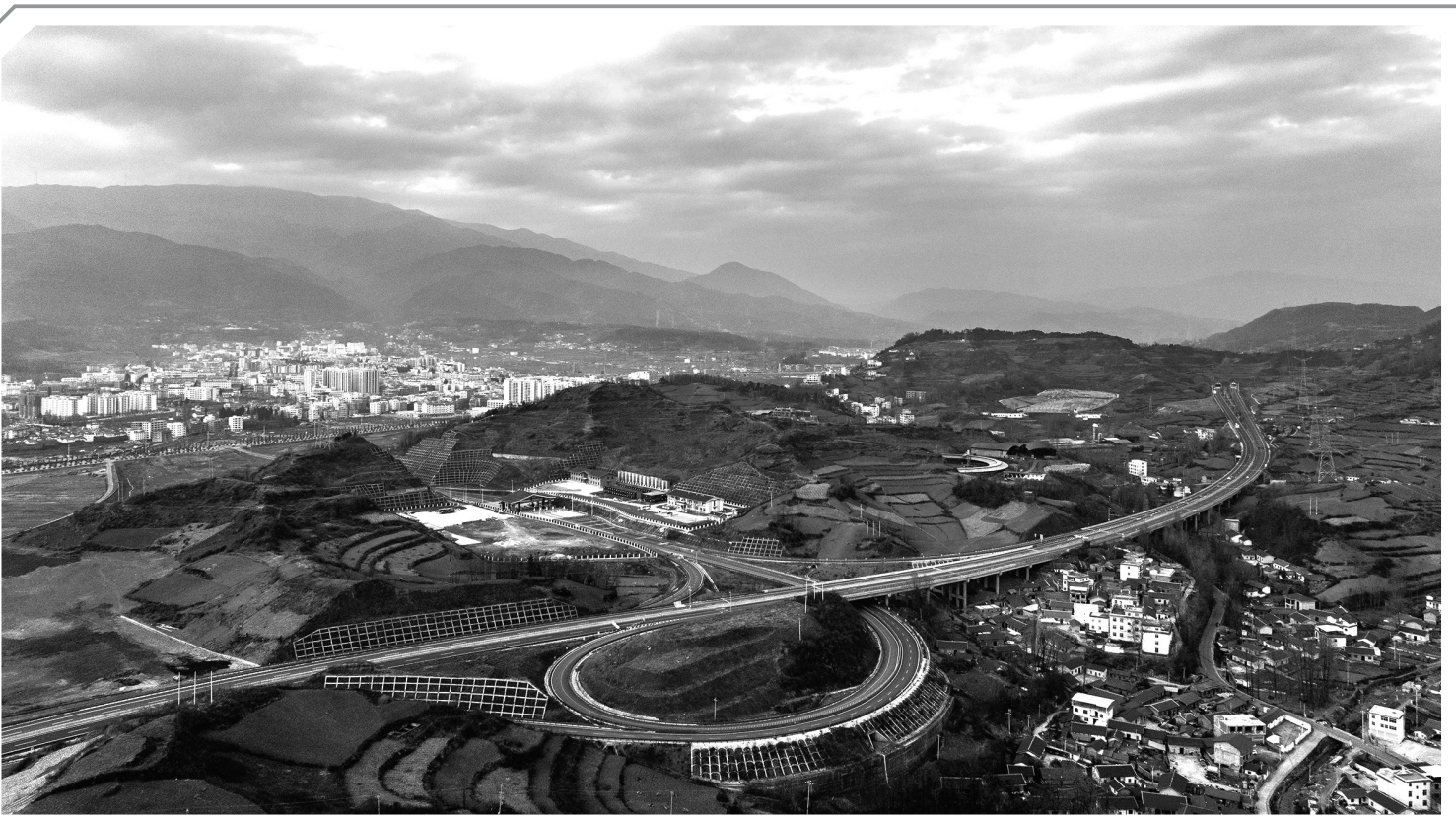
▲乐西高速马昭段通车在即 大小凉山之间将结束不通高速历史 2025年12月26日拍摄的乐西高速昭觉县城出口(无人机照片)。四川乐山至西昌高速公路马边至昭觉段将于2026年1月1日0时通车。乐山市马边彝族自治县地处小凉山，凉山彝族自治州昭觉县地处大凉山。这条连通大小凉山的高速公路，将改写彝乡闭塞的历史，使当地乡村振兴驶入“快车道”。这段高速公路全长约152公里，桥隧比高达82%，概算总投资335.32亿元。它的开通将使昭觉县至马边县的车程从过去的5个小时缩短至1.5小时。昭觉到成都的车程也将从9小时缩短至4小时。未来，与之相连的昭觉至西昌高速公路通车后，成都平原与攀西地区之间将再添一条交通大动脉。(新华)
