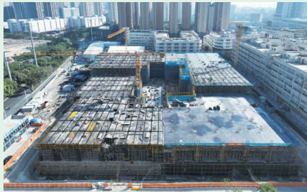
位于同兴路边的健健科技园二期,主体结构施工正加速推进,预计在2026年底,这里将崛起5栋现代化标准厂房,为灵秀镇推动园区连片开发、纺织服装产业集群发展增加新的支撑。(记者 康清辉 李荣鑫)
