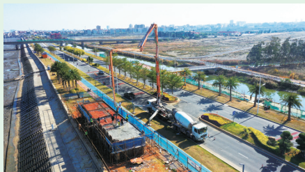
石狮锦江外线服务驿站工程建设提速,目前已进入主体结构收尾阶段,预计2026年上半年投入使用。建成后,该驿站集游客服务、休憩观景、景观带展示等功能于一体。(记者 兰良增 颜华杰)
