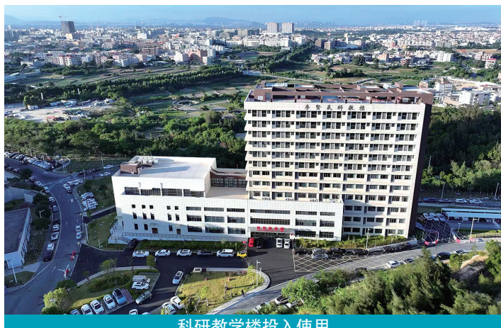
科研教学楼投入使用
