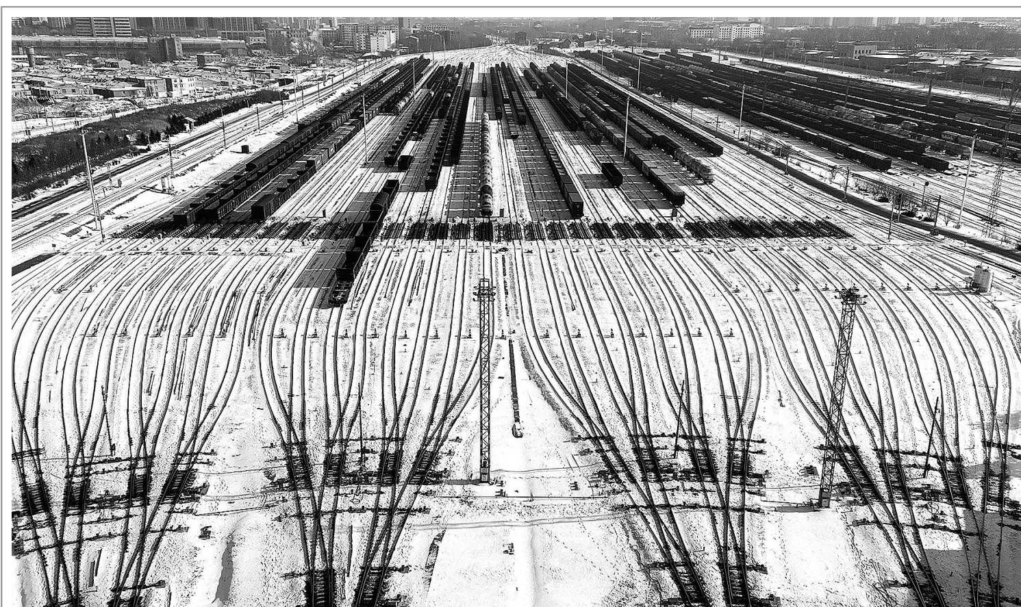
▲哈尔滨:铁路部门全力保障冬季物资运输 1月15日,装满物资的货运列车在黑龙江省哈尔滨南站编组站整装待发(无人机照片)。“三九”天以来,针对北方降温降雪天气,中国铁路哈尔滨局集团有限公司哈尔滨南站积极开展电煤、生产物资保供专项行动,高质量编制运输计划,缩短作业时间,精准提供运力保障,日均解编货物列车13000余辆,全力保障民生物资运输需求。(新华)
