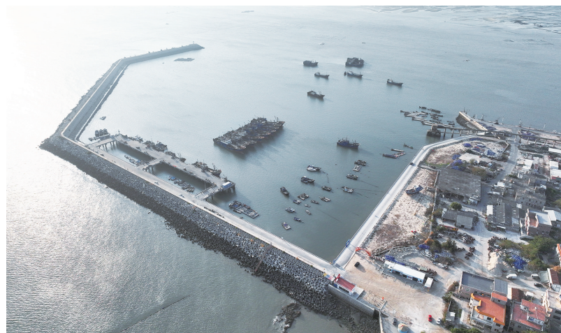
2月2日,石狮市梅林一级渔港工程项目经过省级专家组严格评审,顺利通过竣工验收,标志着永宁镇渔业基础设施建设迈上新台阶。梅林一级渔港项目于2014年开工,主要建设防浪堤980米、码头179米,渔港管理办证中心500平方米,回填陆域8120平方米,港池航道开挖1550立方米,以及水电、环保、通信导航、消防船等配套工程和设施等。(记者 许小雄 李荣鑫)
