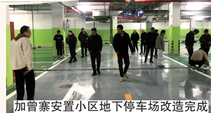
加曾寨安置小区地下停车场改造完成
