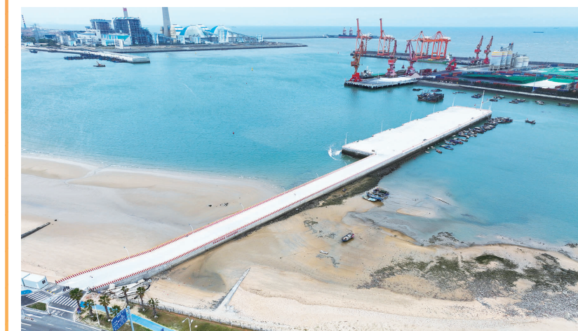
日前,石狮市锦尚东店一级渔港工程顺利通过交工验收,标志着该项施工任务高质量收官,为渔港正式投用奠定坚实基础。作为石狮市重点渔业基础设施建设工程,东店一级渔港工程设计年卸港量4.25万吨,主要建设北防波堤兼码头315米、南码头200米、南引堤196米,改造北引堤353米。 (记者 许小雄 李荣鑫)
