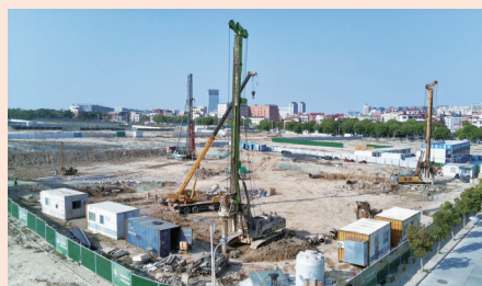
地下室土方开挖、桩基打桩……继最早进场的瑞享至选食品公司办公综合楼项目后,近期灵秀山电商生态产业园又有四个地块的项目先后进场动工。(记者 康清辉 李荣鑫)
