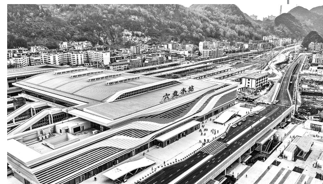
▲贵州六盘水火车站南站房正式投入运营 六盘水火车站南站房(无人机照片,4月1日摄)。近日,贵州六盘水火车站南站房正式投入运营,开始为旅客提供候车、售票、改签等客运服务,六盘水站既有北站房同步停止使用并进入改造施工。本次投用的南站房及配套采用高架跨线候车、“上进下出”的流线布局。旅客无需出站即可在候车室办理改签、退票等业务,有效提升了进出站效率与候车舒适度。(新华)
