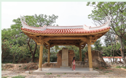
作为石狮新建蚶江海防官署碑记保护性设施及周边环境整治工程(一期)的核心项目,一座全新的原木结构保护棚日前顺利通过验收。(记者 兰良增 颜华杰)
